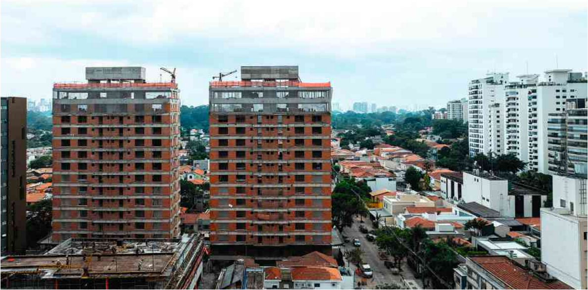
Prédios residenciais em fase de construção na zona sul de SP Danilo Verpa - 14.abr.24/Folhapress
