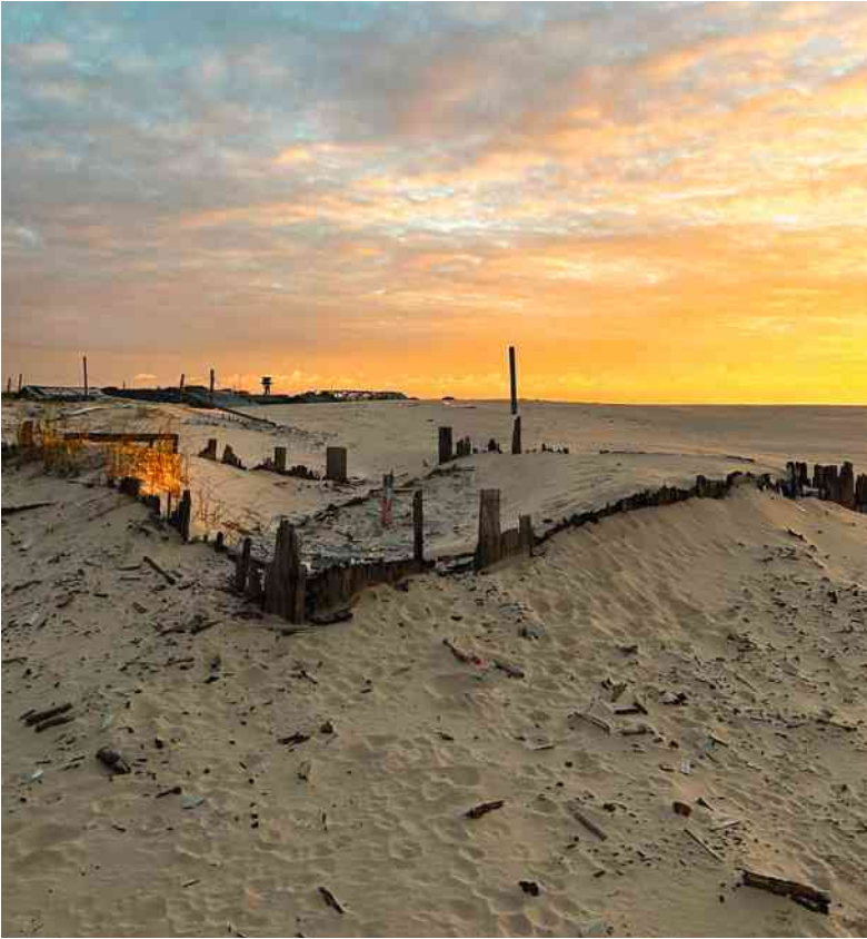
Areia avança sobre estrutura de quiosque na praia da Costa do Sol em Cidreira, no litoral norte do Rio Grande do Sul
